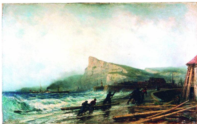
Рис. 3. Боголюбов А.П. Фекан. Строительство дамбы. 1870-е. Холст, масло. 45,2 x 73,3. Частное собрание. Фото ВХНРЦ.
