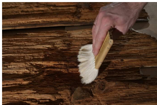
Рис. 5. Пропитка древесины радиальных граней укрепляющим составом в мастерских Центра Грабаря. 2017. Фото ВХНРЦ.
