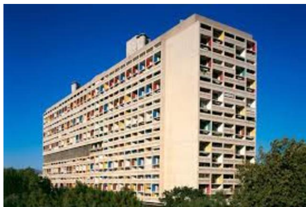
Рис. 4. Ле Корбюзье. Жилая Единица. Южный фасад. Марсель. 1945-1952. Источник: http://probanhaus.ru/architecture/residential-architecture/page/2/
