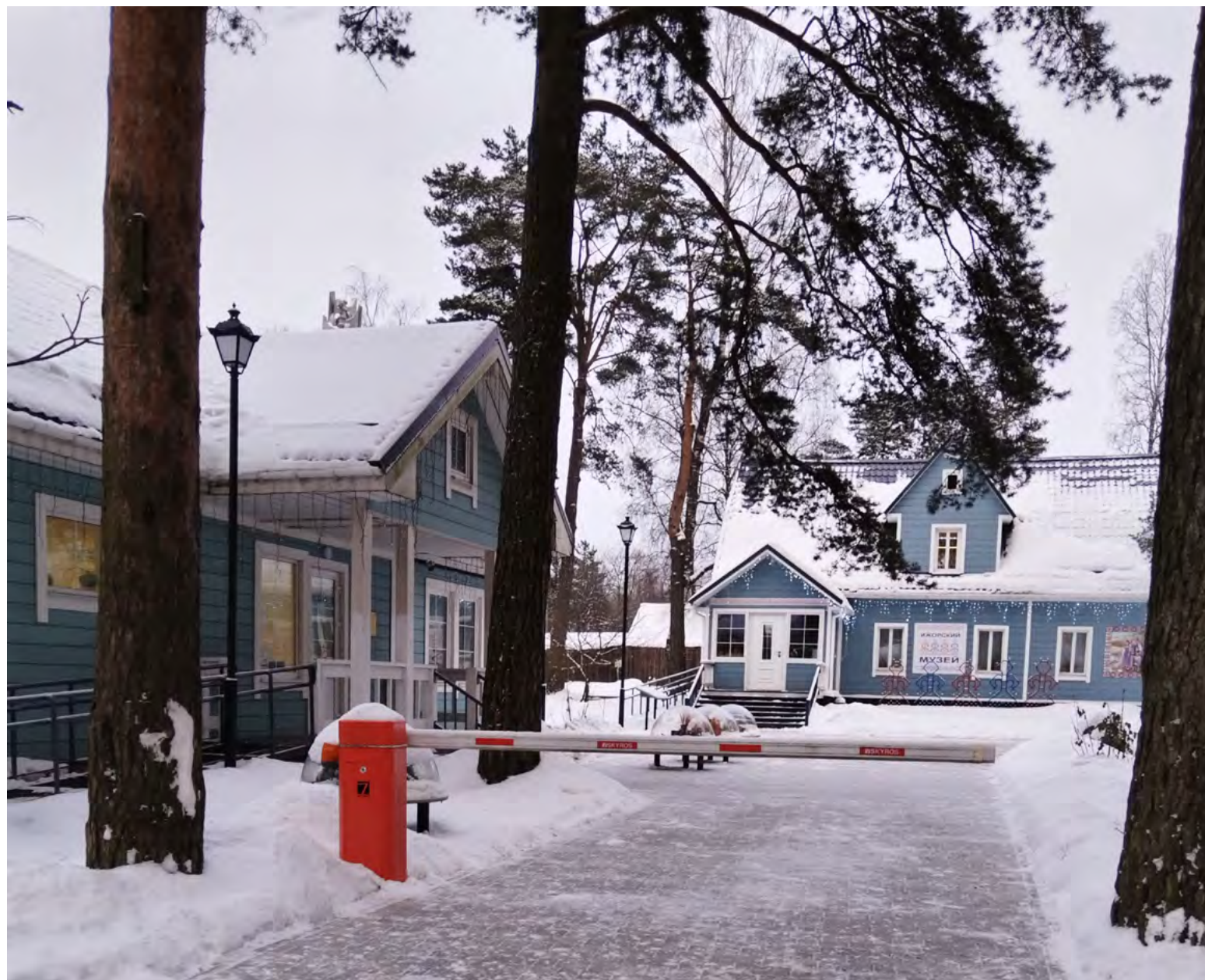
10. Здание Ижорского музея.
